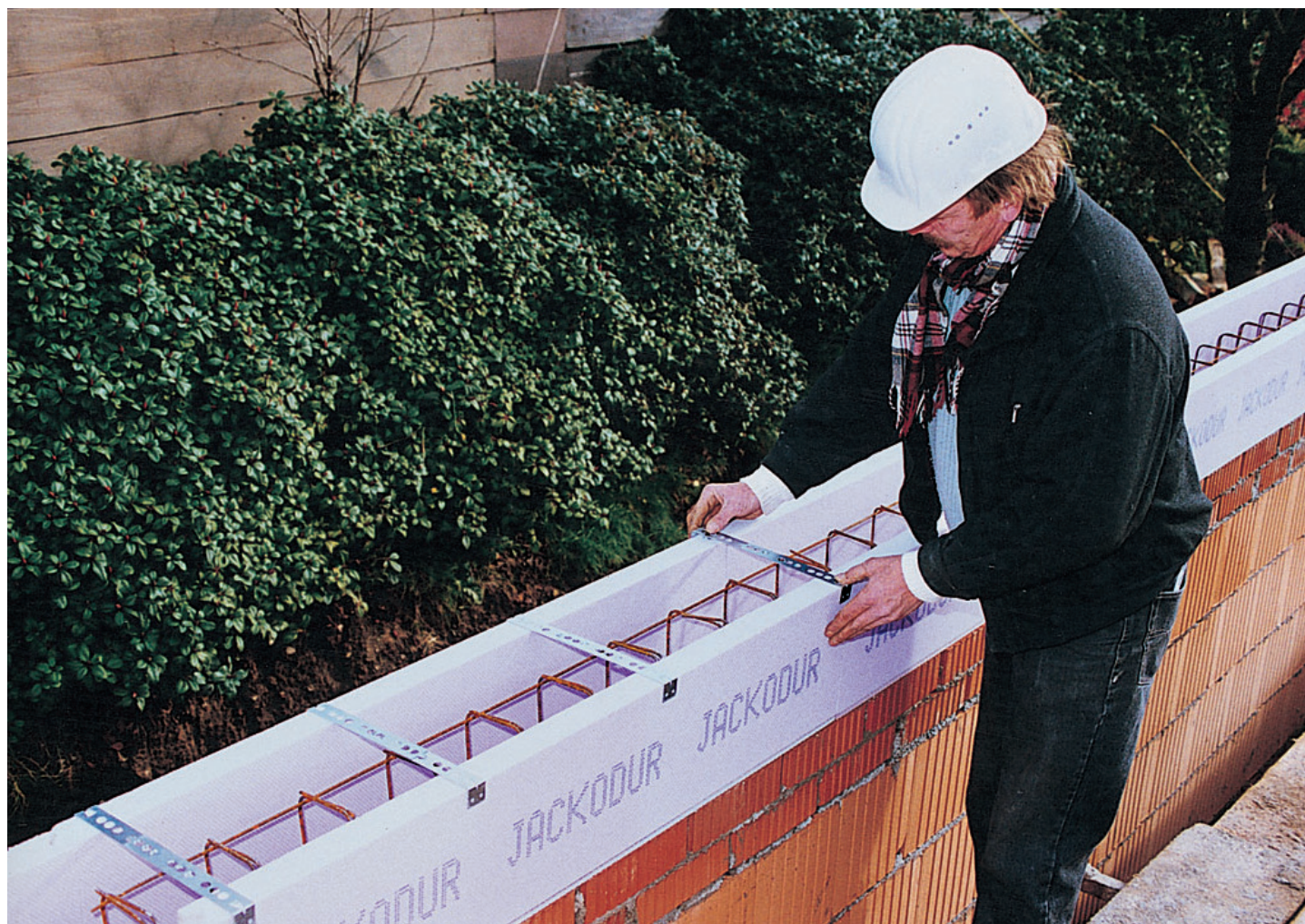
Photo 1 : Poutre de ceinture avec planelles isolantes JDS (Plus) JACKODUR®
