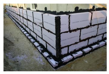
Bild: Verarbeitung der Perimeterdämmung im drückenden Wasser (Grundwasser)
