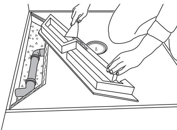
**7)** Anschließend wird auf der Unterseite der Rohrab-deckung Fliesenkleber aufgetragen.
